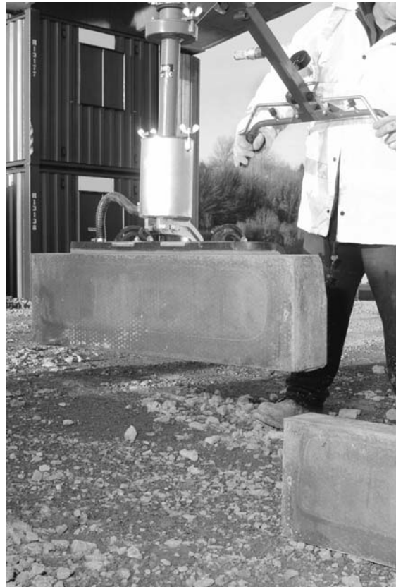
Rysunek 1 Transport krawężników przy użyciu podnośnika próżniowego
