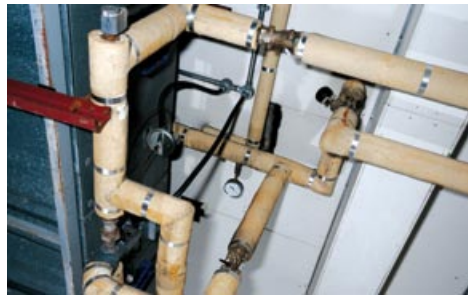
Ynysiad pibell asbestos
