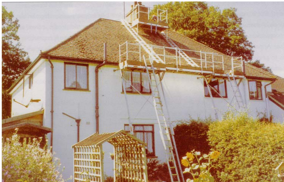
Figura 3 Sistem de acces brevetat pentru munca pe acoperișuri
