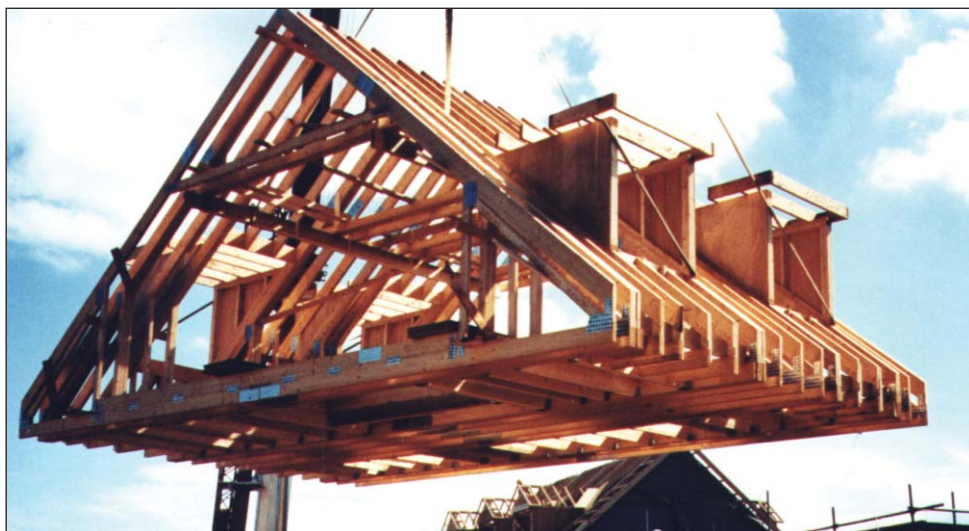
Figura 6 Șarpantă construită la sol și ridicată în poziția finală nefiind necesar a se lucra deasupra planșeului din grinzi
