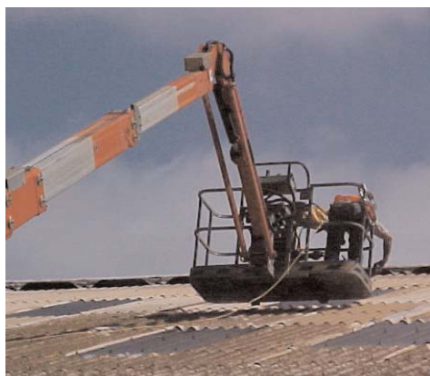
Figura 4 Platformă de lucru elevatoare folosită pentru a înlocui o foaie de tablă pe un acoperiș
