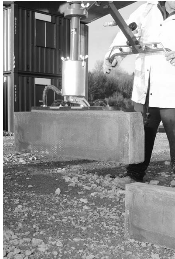
Figura 1 Manipularea bordurilor cu un sistem de ridicare prin vacuum
