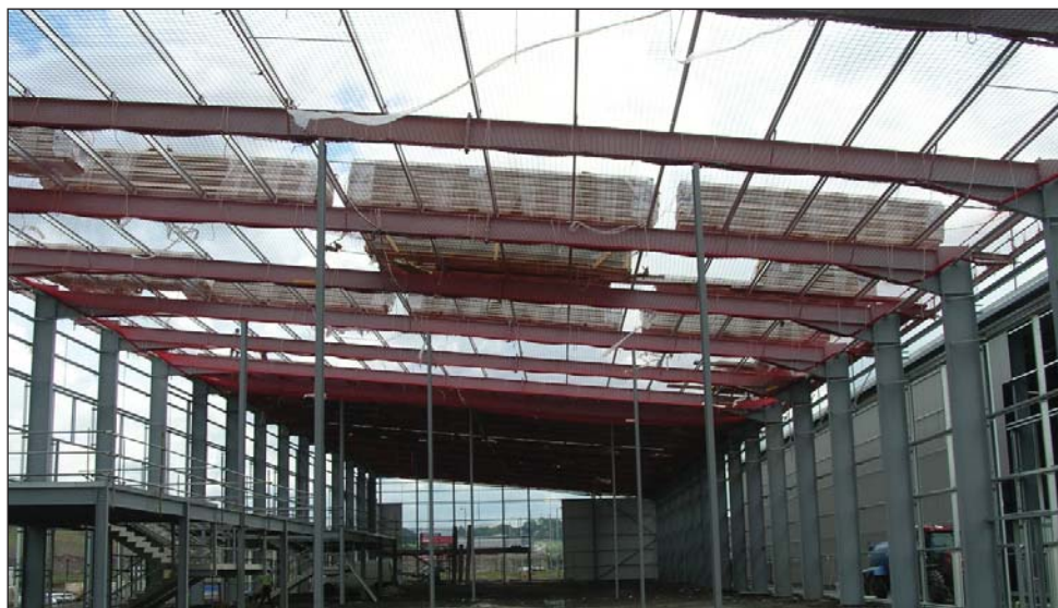
Ilustracja 7. Siatki bezpieczeństwa zamontowane przed ułożeniem pokrycia dachowego. Siatka jest podwieszona możliwie jak najbliżej pod dachem w celu zminimalizowania długości upadku.
