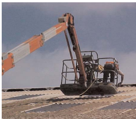
Ilustracja 4. Wykorzystanie przejezdnego podestu ruchomego przy wymianie pokrycia dachowego
