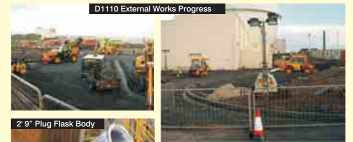
D1110 External Works Progress
