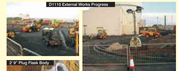
D1110 External Works Progress
